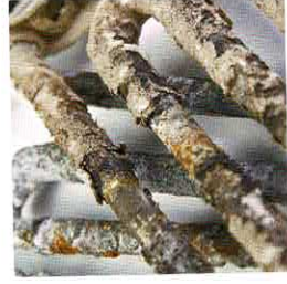
Fot. 70. Kamień kotłowy na grzałce pralki.
