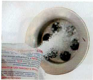
Fot. 42. Wodorotlenek sodu reaguje z tłuszczami, dlatego skutecznie usuwa tłuste zanieczyszczenia zgromadzone w rurach.
